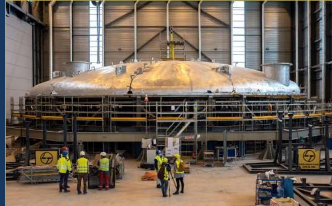
Fabriquées en Inde les différentes sections du Cryostat sont assemblées et soudées sur site. La base et le cylindre inférieur sont en place dans la fosse d'assemblage, le cylindre supérieur est stocké dans l'attente de son installation et les éléments du "couvercle" sont prêts à être ajustés avant soudage.
