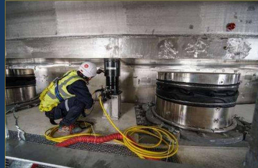
Un système de vérins hydrauliques a supporté la base dans l'attente des opérations finales d'ajustement avec des coins de plus de 1m de diamètre ajustés au mm près.
