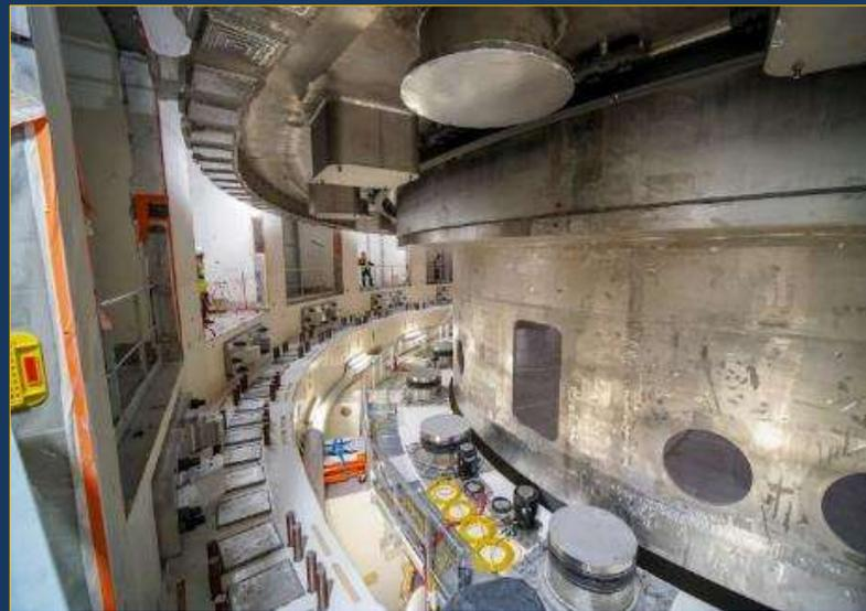
Elle repose sur un système de support (ancrages et rotules) qui redistribue les forces horizontales et de torsion générées par la production de plasma dans le Tokamak.
