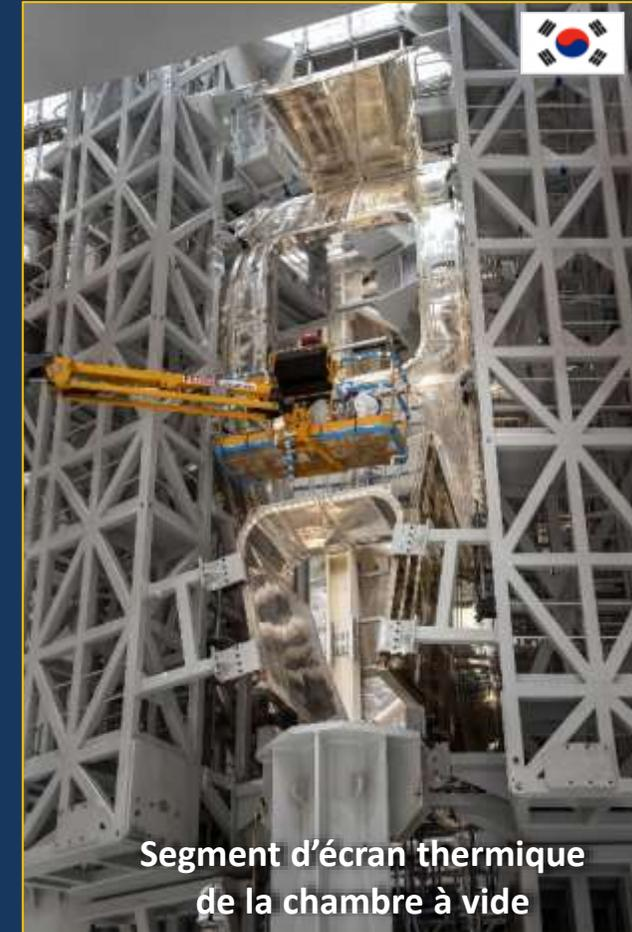
1 secteur de chambre à vide (40°) + segment d'écran thermique correspondant + 2 bobines de champ toroïdal = 1 pré-assemblage.
