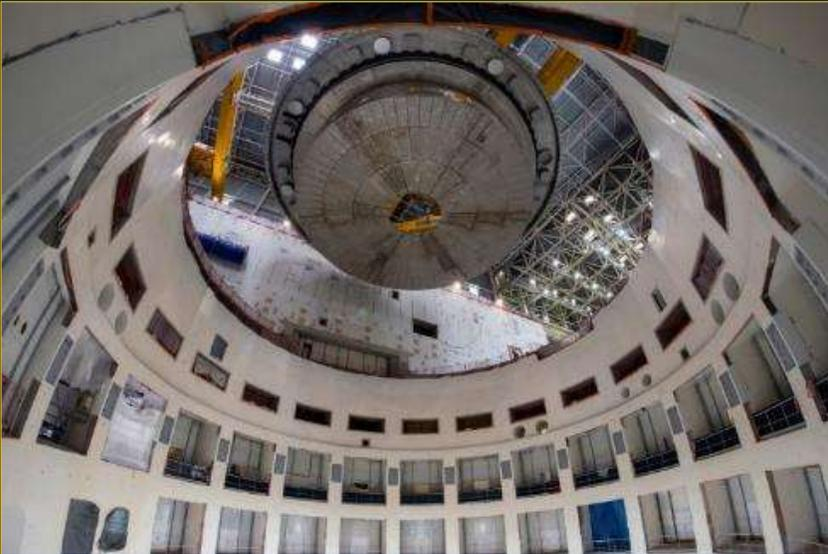
La base du Cryostat (30 mètres de diamètre, 1 250 tonnes) est la plus massive des pièces de la machine. C'est une des quatre sections du « thermos » géant, fourni par l'Inde, qui enveloppe le Tokamak.
