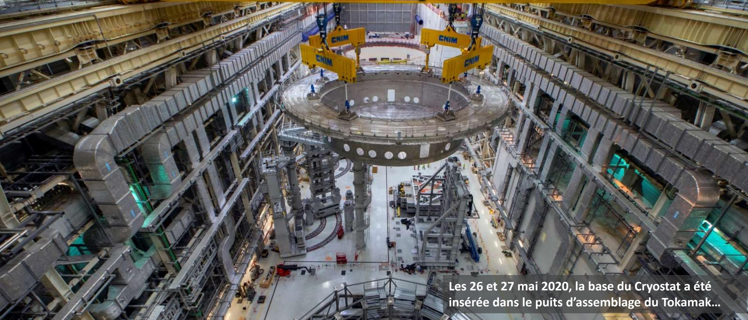
Les 26 et 27 mai 2020, la base du Cryostat a été insérée dans le puits d'assemblage du Tokamak...
