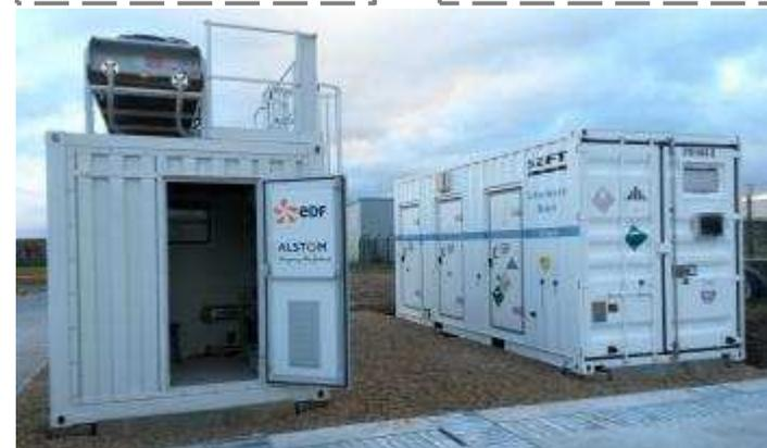
Onduleur ALSTOM et batterie SAFT (1 MW – 30 minutes) installés sur Concept Grid à EDF Lab Les Renardières
