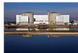
Fessenheim 2 réacteurs à eau pressurisée Mise en service : 1971, 1972 Date d'arrêt : 2020 Décret démantèlement : en cours d'instruction
